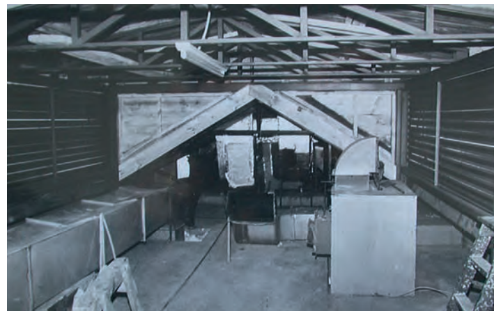
Instalación de los equipos de aire acondicionado donados por el gobierno japonés, en el entretecho del edificio, en 1991. Fotos Luis Cornejo, Archivo MCHAP.
