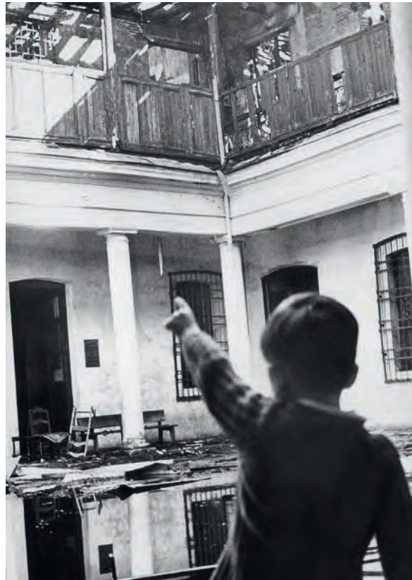
Patio norte del edificio de los "Tribunales Viejos" durante su restauración. Foto El Mercurio , diciembre de 1978, Archivo MChAP.
