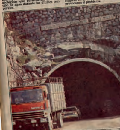
TUNEL REHABILITADO.— El tránsito por el túnel "La Calavera", abierto ayer en la Ruta Cinco Norte, fue abierto ayer en la mañana para toda clase de vehículos. Simultáneamente se prosigue con faenas de reparación. El viaducto se encontraba inhabilitado desde el 30 de julio, debido a un derrumbe ocasionado por fallas geológicas. La oficina de Vialidad señaló que entre el lunes 20 y el jueves 24 se volverá a interrumpir la circulación vehicular, por la ejecución de trabajos complementarios.
