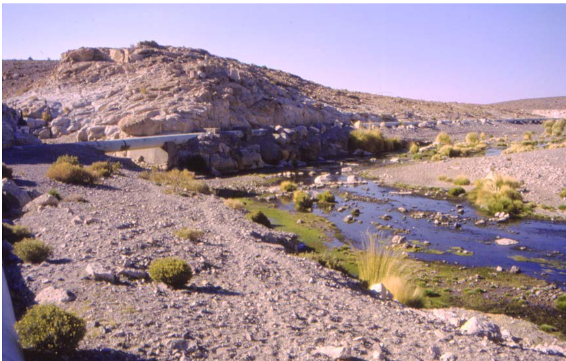
8.12 Cañerías en el desierto. Foto José Berenguer, 1989.
