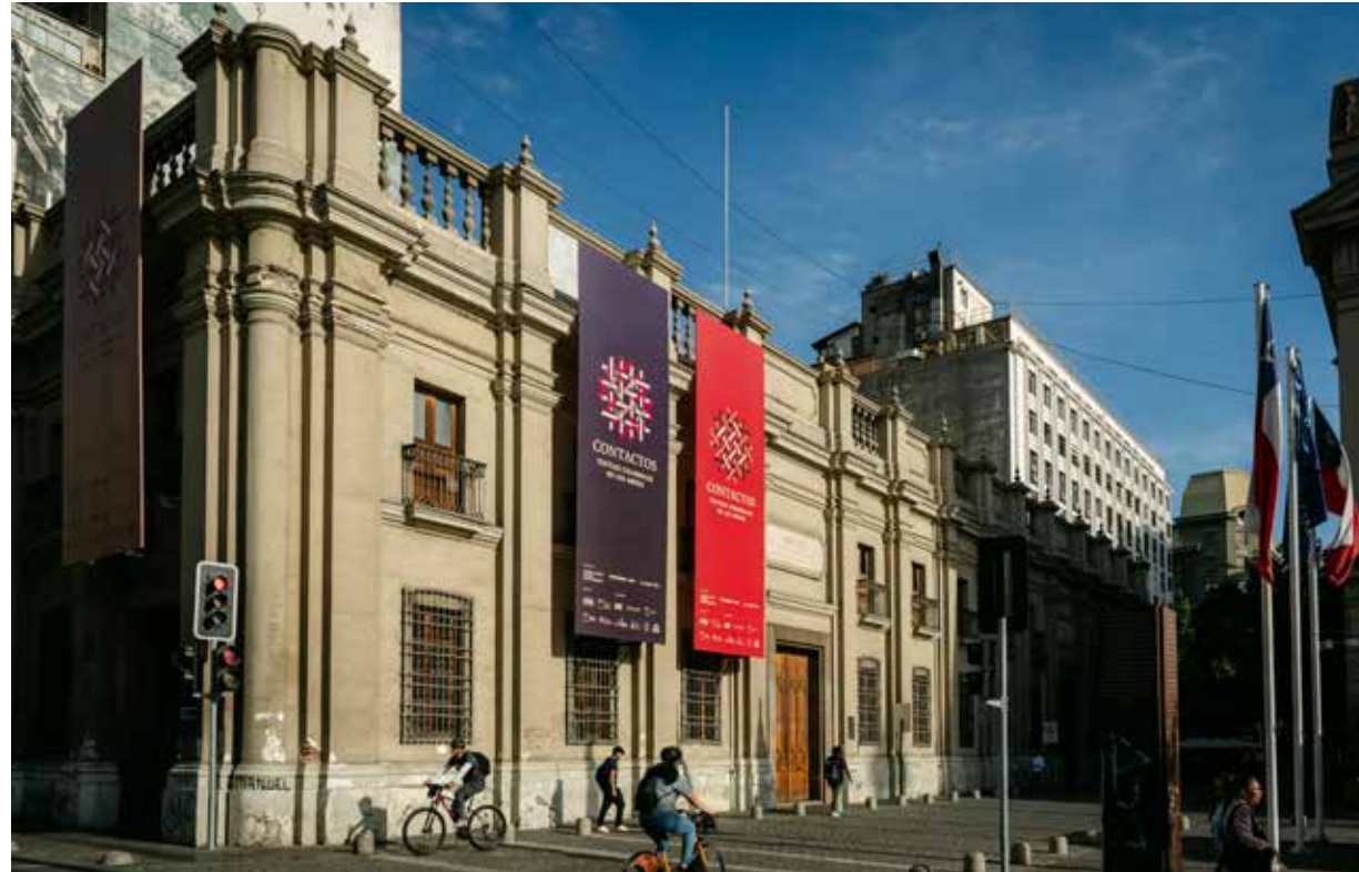
Fachada del Museo durante el primer semestre de 2025. Un desafío urgente es restaurar el edificio patrimonial.
